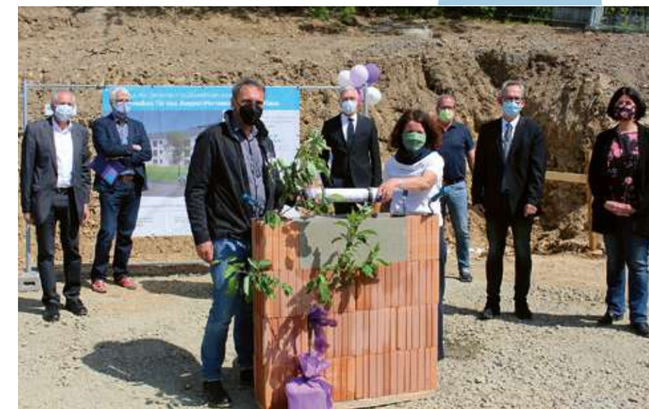
Die Zeitkapsel versenken Einrichtungsleiterin Margit Haars und Geschäftsleiter Achim Krugmann im Grundstein des Neubaus.
