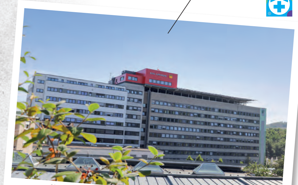
2021: Das neue Landedeck mit Hangar thront hoch oben auf dem Krankenhausedach.
