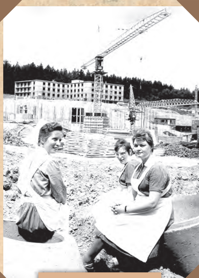
Besuch auf der Baustelle: Drei Krankenschwestern beobachten, wie ihr neuer Arbeitsplatz in die Höhe wächst.
